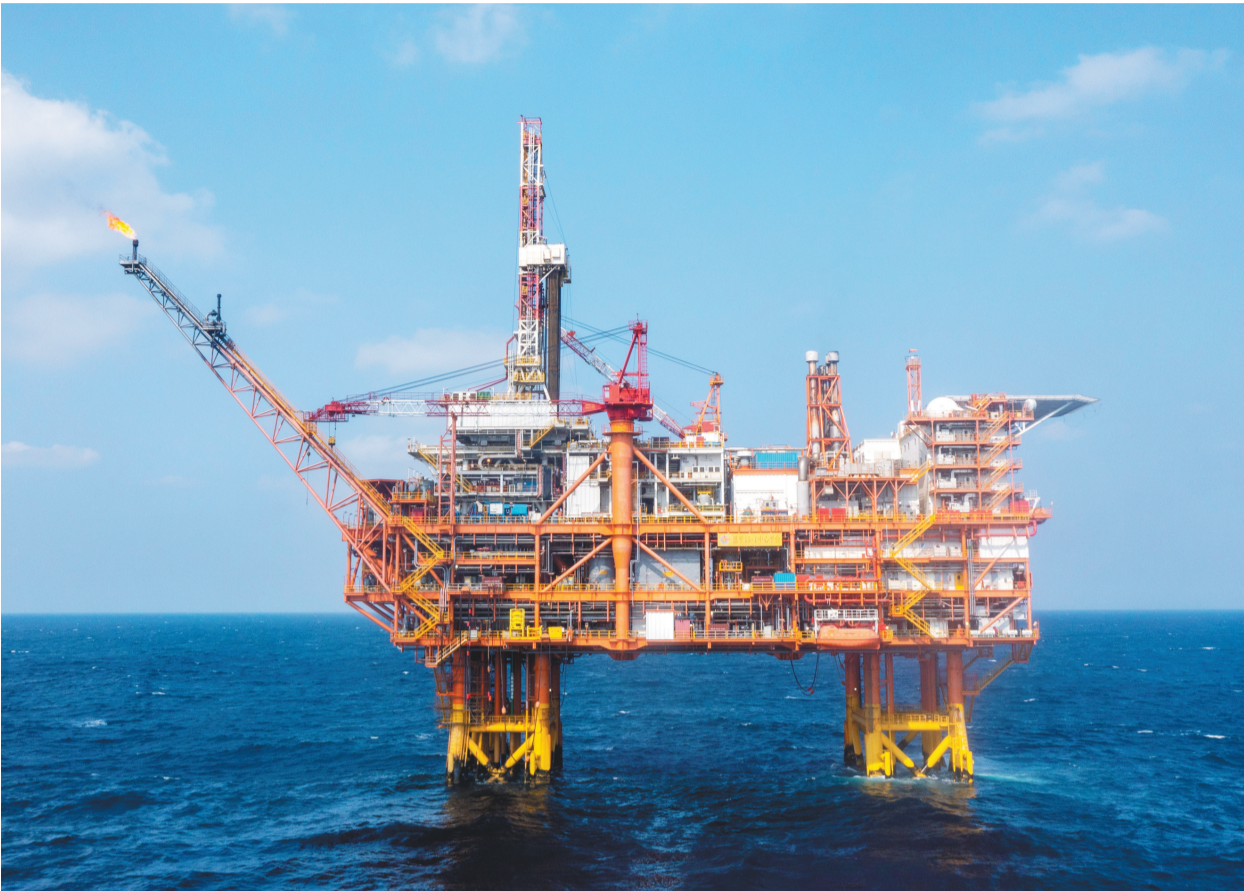
图为我国首个海上二氧化碳捕集、利用与封存(CCCUS)项目在珠江口盆地的恩平15-1平台投用。
