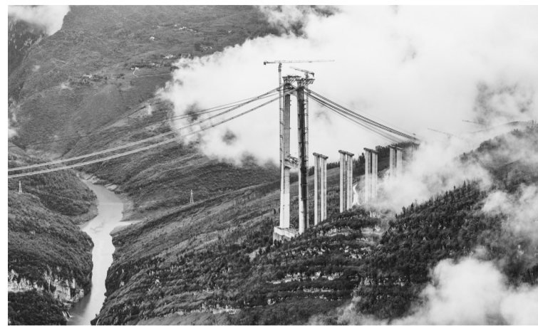
这是建设中的安盘高速天门特大桥(5月28日摄,无人照照片)。眼下,由中铁广州局承建的贵州安(安顺)盘(盘州)高速天门特大桥正抢抓工期,加紧建设,有序推进边跨索夹安装。天门特大桥是安顺至盘州高速公路的重要控制性工程,大桥全长1553米,桥面距峡谷水面约560米,设计时速100公里。
