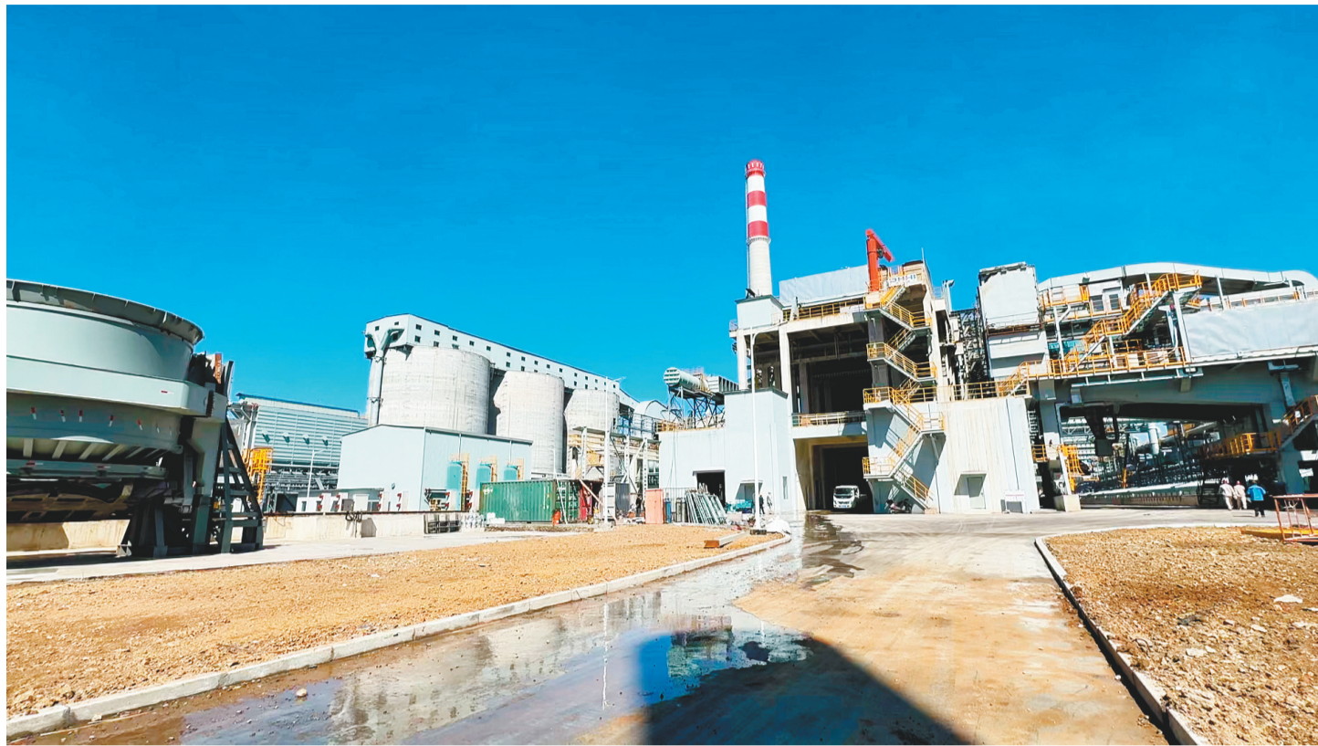
凌钢钢焦一体化及焦炉煤气制LNG项目建设现场。
