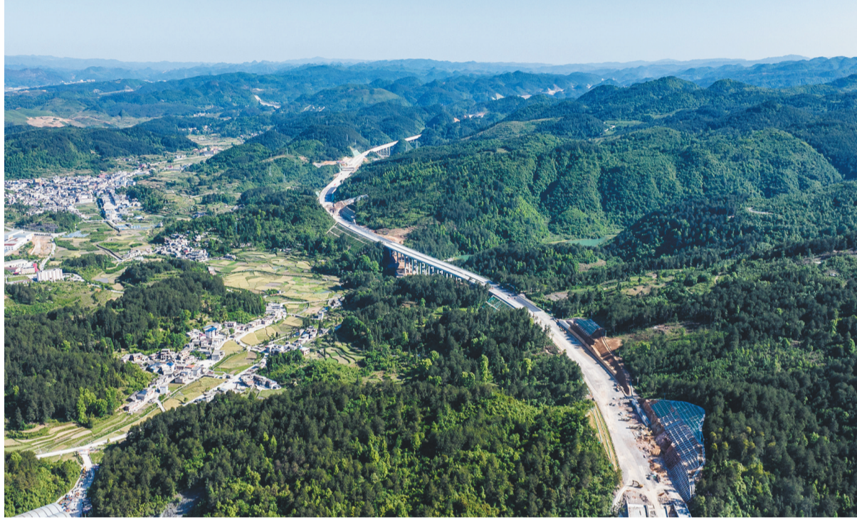
由贵州交投集团投资建设的贵阳至平塘高速公路正抢抓工期火热施工,项目工程整体进度已完成85%,施工建设进入冲刺阶段。贵平高速起于贵阳市乌当区羊昌镇,止于黔南布依族苗族自治州平塘县四寨镇云阳关,顺接广西的天峨至北海高速公路。项目路线全长174.018公里,设计时速100公里,预计于今年年底全线建成。图为建设中的贵平高速三元至沿山北路段。 新华社记者 陶亮 摄
