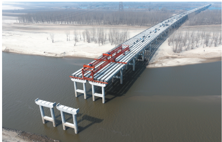
鞍山高速公路沙坨子辽河特大桥已经完成58孔桥面铺设进度。
