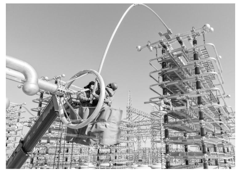
3月21日,在巴里坤换流站,施工人员进行电容器组设备引线安装。近日,国家“十四五”重大工程——哈密—重庆±800千伏特高压直流输电工程(简称“疆电入渝”工程)新疆送端站——巴里坤换流站顺利完成14台双极低端换流变压器的安装工作,标志着“疆电入渝”工程进入最后攻坚冲刺阶段。
