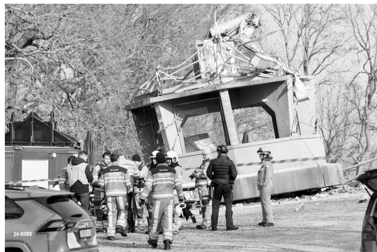
3月16日,在荷兰法尔肯堡,救援人员在石塔坍塌现场工作。荷兰南部小镇法尔肯堡一座百年石塔16日凌晨突然倒塌,原因不明。救援部门已动用无人机和嗅探犬展开搜救工作,目前未发现人员伤亡。这座新哥特式建筑名为威廉敏娜塔,建于1906年,高30米,是当地颇受欢迎的景点。新华社发
