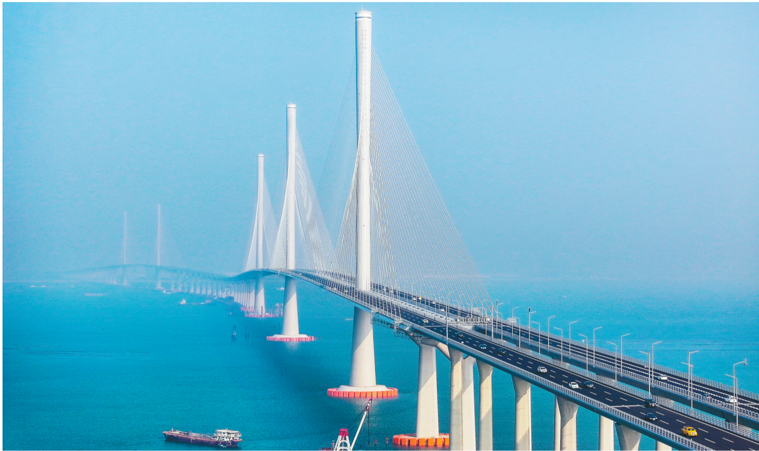
黄茅海跨海通道正式通车后,车辆行驶在黄茅海大桥上(2024年12月11日摄,无人机照片)。
