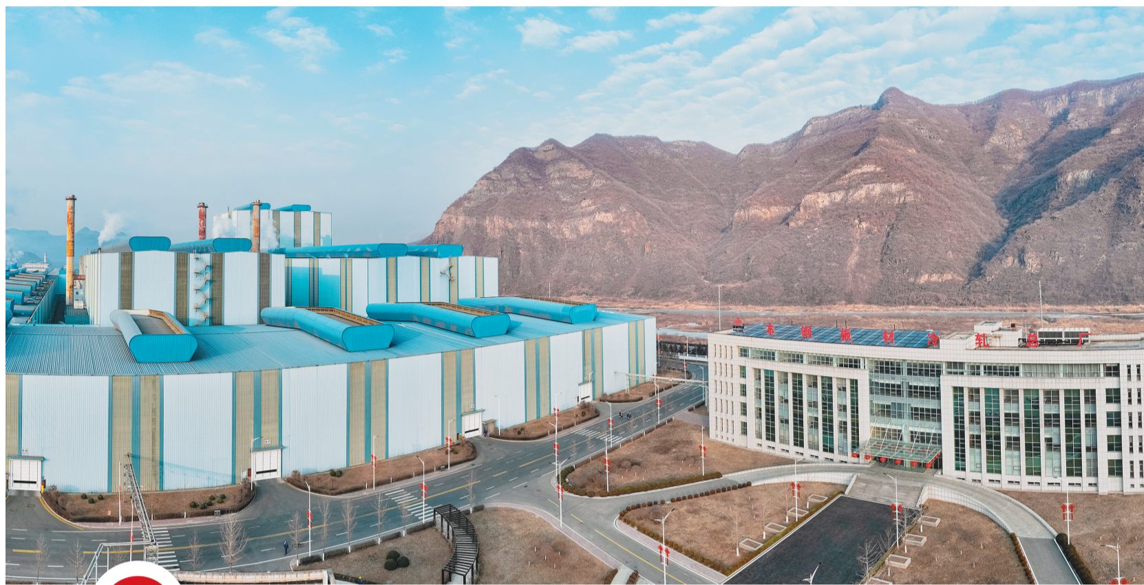
本钢板材冷轧总厂第三冷轧厂外景。
