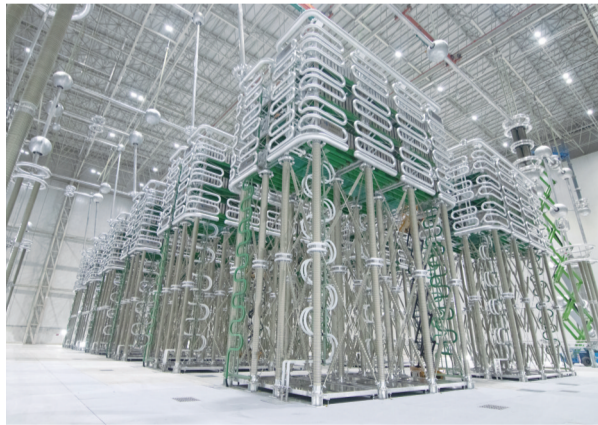
荣信汇科电气股份有限公司生产的柔性直流换流阀。
