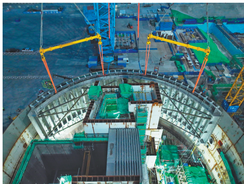
日前，徐大堡核电厂1号机组CA03模块吊装就位。中核集团葫芦岛徐大堡核电项目是我省“十四五”期间单体投资最大的清洁能源项目之一。项目建成后，每年可提供近540亿千瓦时的清洁能源。 本报特约记者 田嘉 摄
