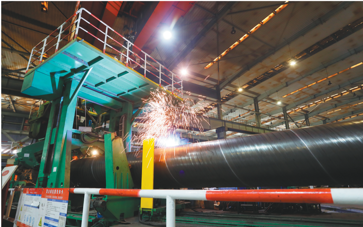
按照工艺要求对制管一机组生产线上的钢管进行等离子切割。
