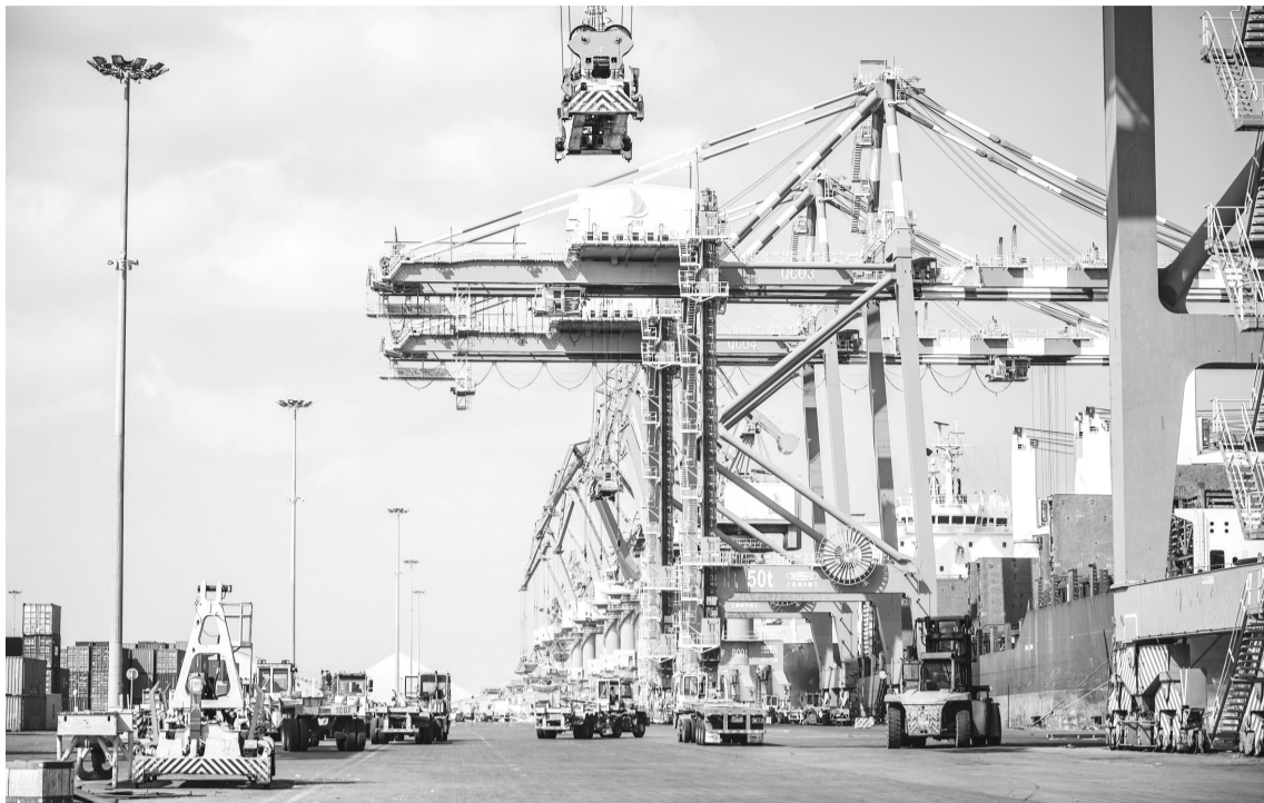
这是十一月八日在吉布提首都吉布提市拍摄的多哈雷多功能港口。由中国招商局集团参与投资和运营的多哈雷多功能港口于二〇一七年正式启用,目前已成为东非最现代化的港口之一。
