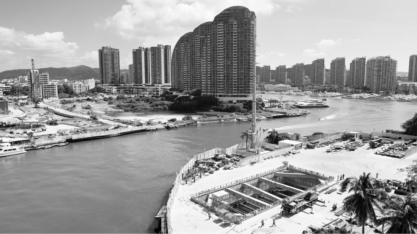
位于海南省三亚市天涯区的三亚河口通道工程项目目前建设稳步推进。该项目由中铁二十局承建,采用国内外首创三圆咬合顶管施工工艺,通过管幕结构加冷冻法施工法的全海底作业方式,确保大量游艇游船进出港不受施工影响,有效保护周边海洋生态。该项目是三亚首个水下隧道工程,隧道总长度3.11km,项目建成后将进一步优化三亚市空间格局,为海南自贸港发展提供有利条件。图为10月12日拍摄的三亚河口通道工程项目现场(无人机照片)。
