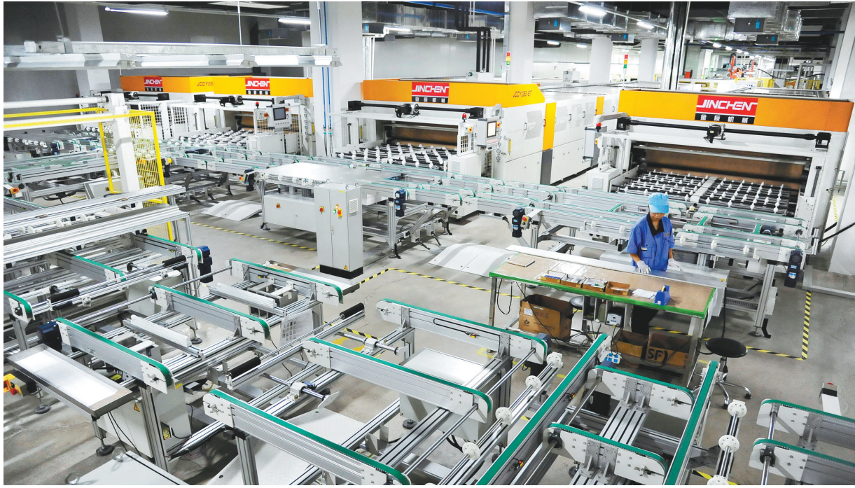
营口金辰机械股份有限公司生产线。
