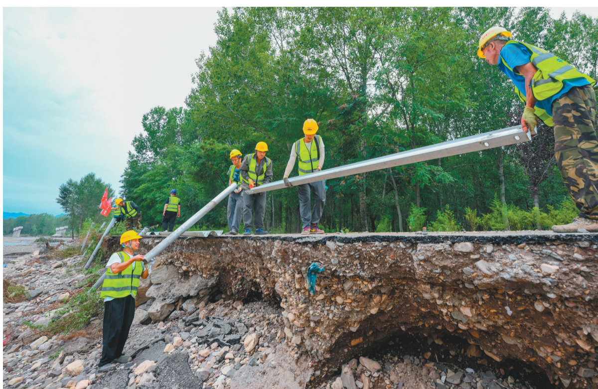
近日,建昌县雷家店乡的杨路线,省交通运输厅防汛办统一指挥调度中铁建投集团、中铁建大桥局的施工人员,对水毁路面展开抢修。
