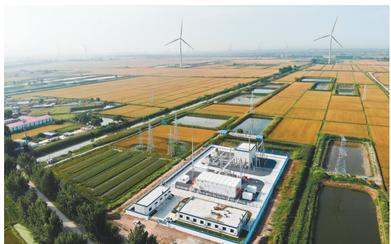
大石桥陆上风电项目的建设可满足当地镁产业大部分用电需求。
