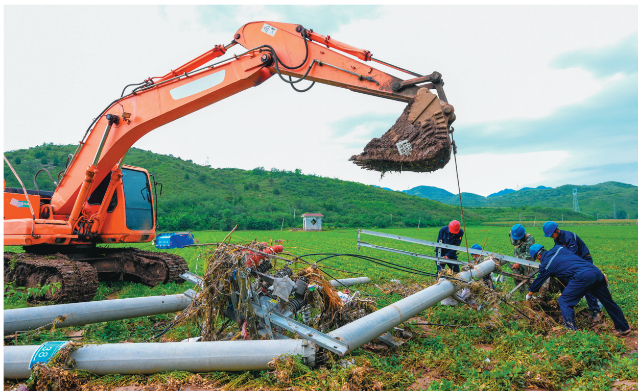
来自锦州凌海市的电力工作人员在建昌县大屯镇抢修水毁电力设施。
