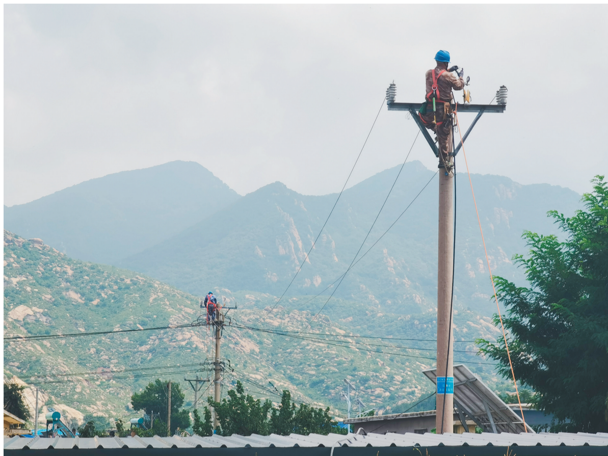
8月21日中午,国网辽宁电力应急抢修突击队对建昌县石佛乡白狼山村10千伏煤矿线进行应急抢修作业。
