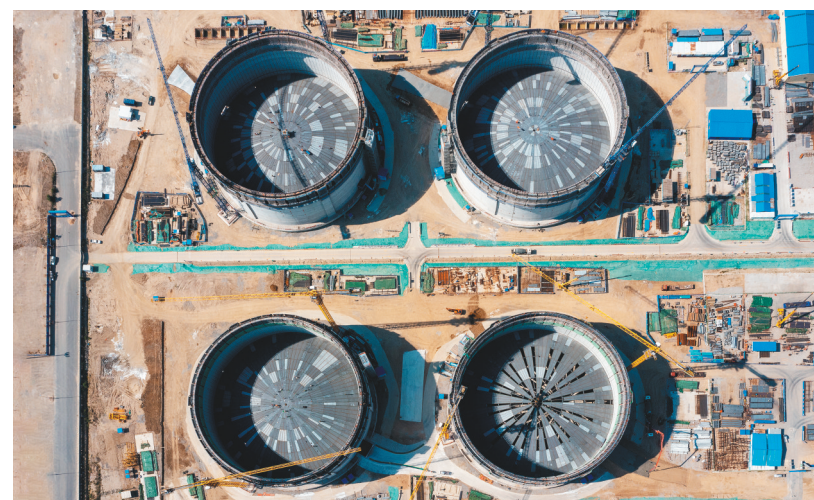
中交营口LNG接收站项目施工现场。
