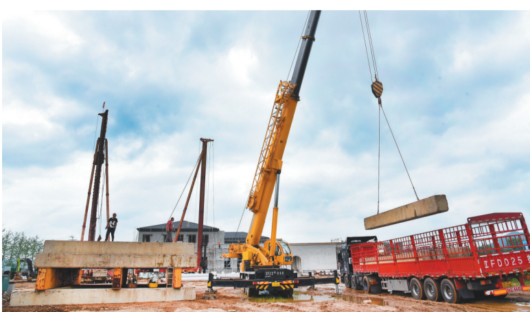
凤凰谷智慧康养中心项目正在施工。
