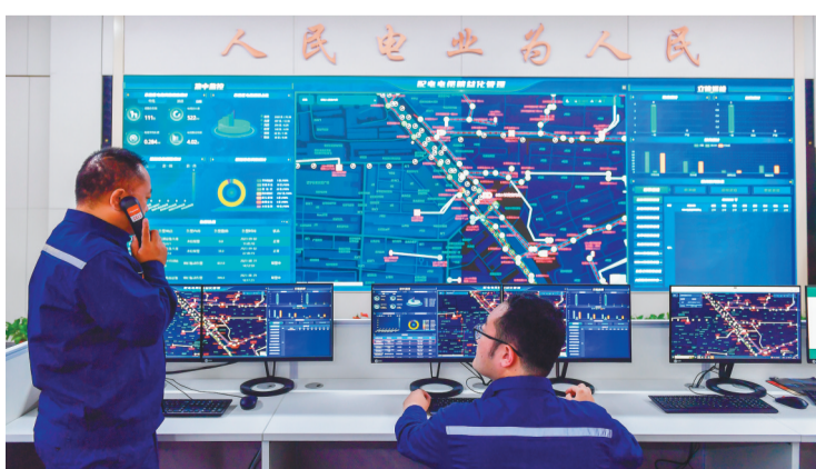
通过配电网精益化管理系统,工作人员对10千伏电缆进行实时监控。
