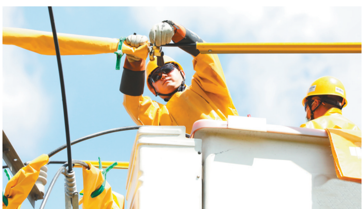
在10千伏线路上,工作人员开展带电接引线作业,剔除导线绝缘层。
