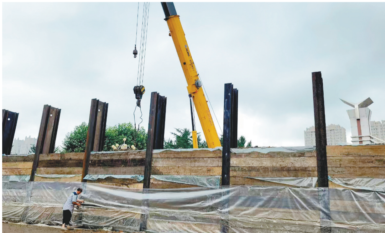
图为工作人员正在拆除坝门封堵。
