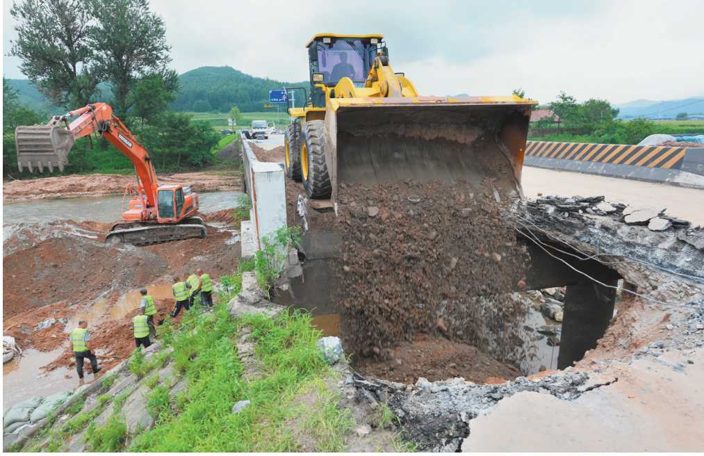
图为丹东凤城市丹霍线薛礼站南桥水毁锥坡抢修现场,大型机械拆解桥台搭板后回填砂石料和水稳料。 本报记者 查金辉 摄
