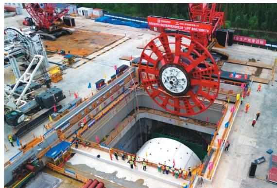
7月24日,“山河号”盾构机刀盘被履带式起重机从地面吊运至济南市黄岗路穿黄隧道盾构始发井(无人机照片)。当日,由中铁十四局集团承建的济南市黄岗路穿黄隧道“山河号”盾构机刀盘顺利吊装下井,为黄岗路穿黄隧道盾构机始发穿黄奠定基础。新华社记者 徐速摄
