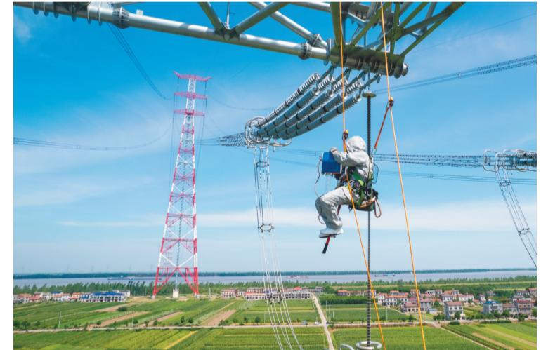
7月23日,在南荆长特高压工程荆湘线,电力工人在对线路进行检修(无人机照片)。为确保迎峰度夏期间电力可靠供应,当日,在湖南省临湘市江南镇,国网湖南超高压输电公司对1000千伏南荆—荆门—长沙特高压交流工程荆湘线进行带电检修。
