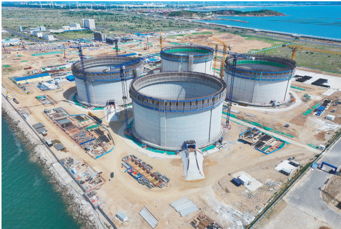
建设中的中交营口LNG接收站项目。
