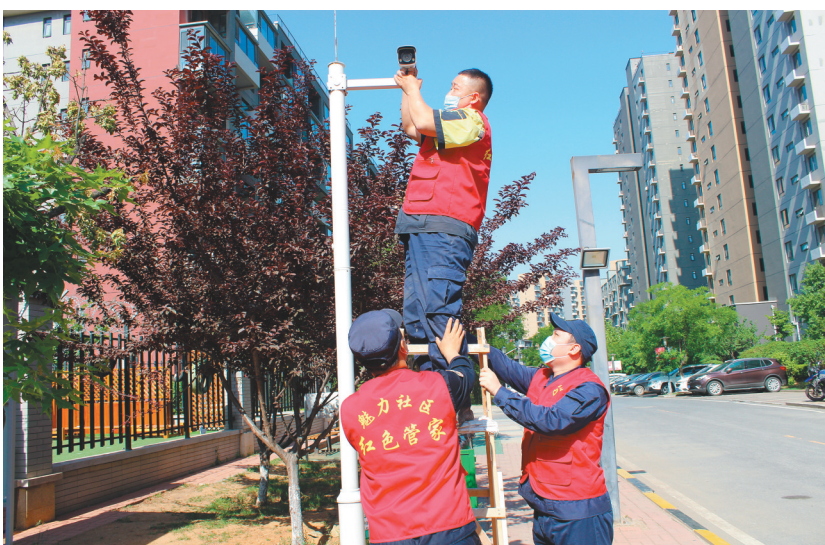
甘井子区辛寨子街道魅力社区“红色管家”及时对故障监控设备进行维修。
