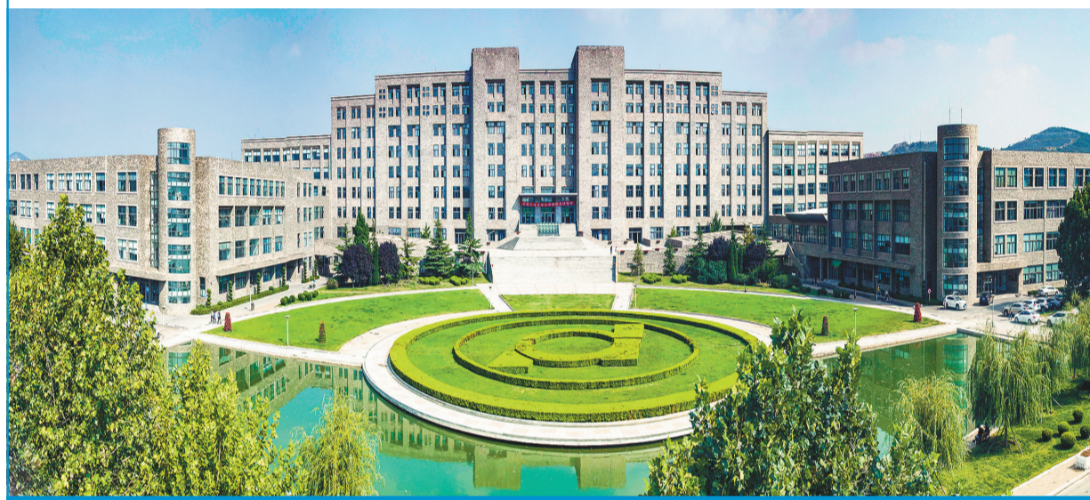
大连工业大学综合教学楼。
