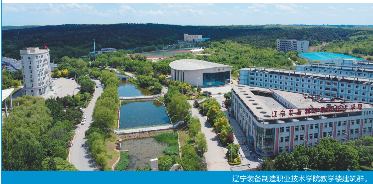
辽宁装备制造职业技术学院教学楼建筑群。
