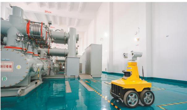
6月17日，轮式机器人正在对220千伏港东变电站进行巡检工作。
