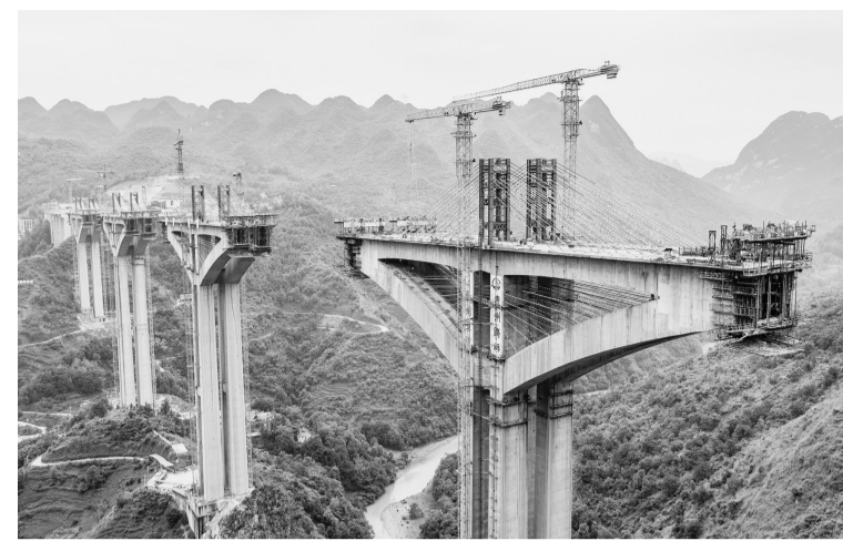
这是建设中的六枝特大桥桥墩(无人机照片,6月17日摄)。
