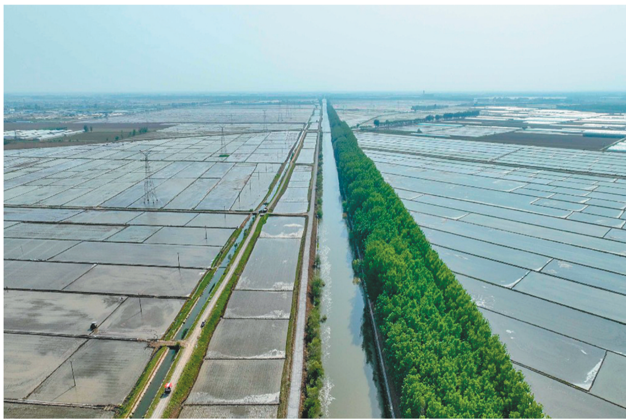
随着浑蒲灌区续建配套与现代化改造工程的推进,灌区的供水保障能力和节水效率明显提升。图为浑蒲灌区水渠。 本报记者 查金辉 摄
