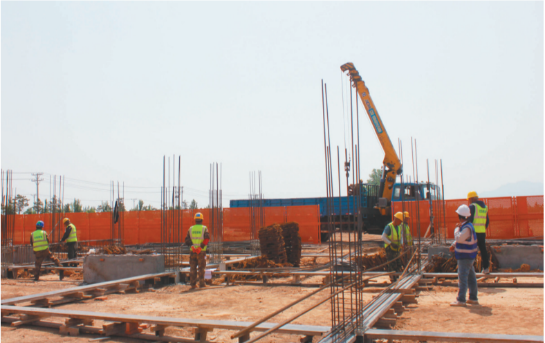
华润雪花30万吨啤酒项目建设现场。
