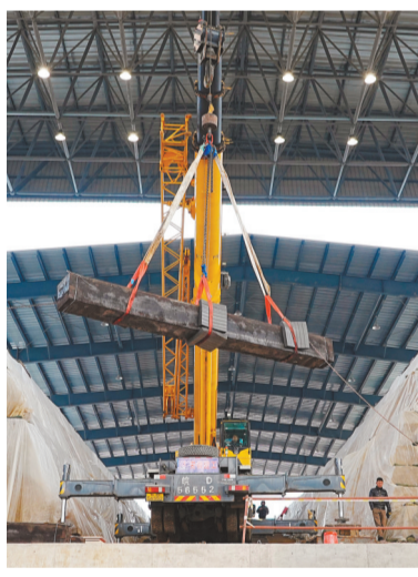
对主墓椁顶盖板进行吊装作业。
