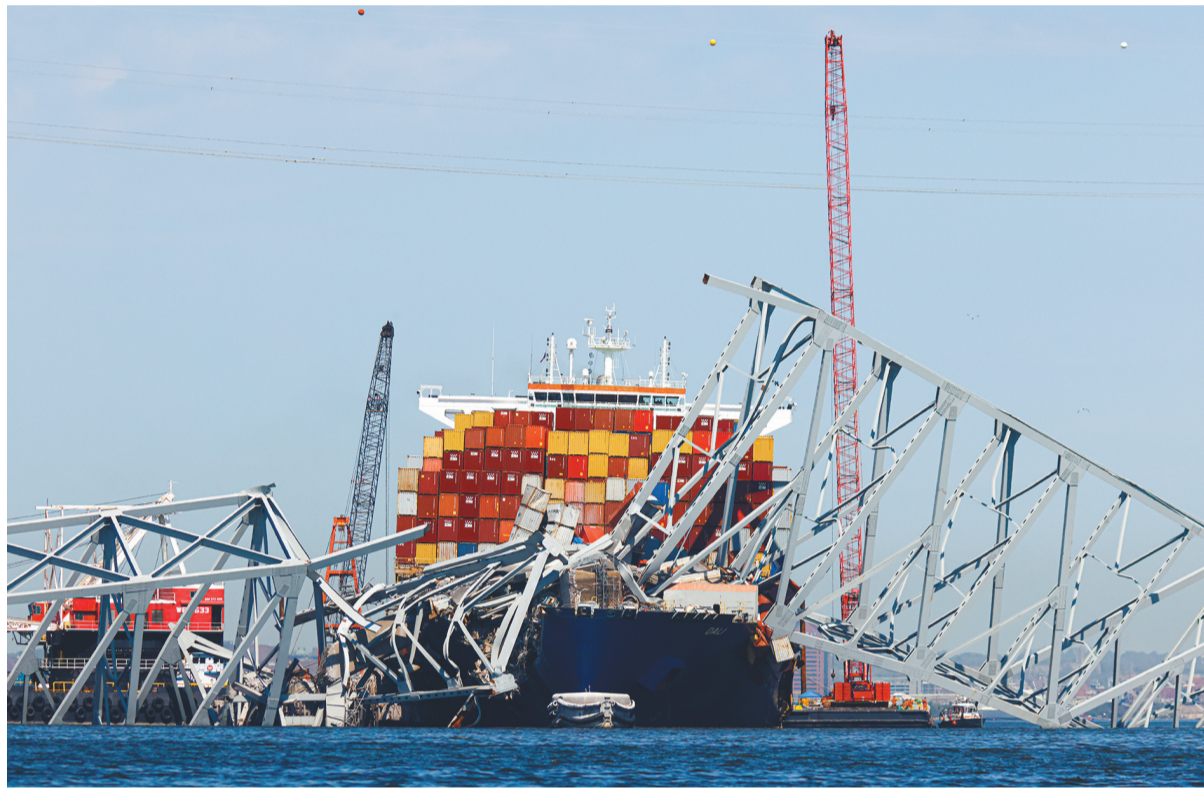
这是4月15日在美国巴尔的摩拍摄的撞桥后坍塌的“弗朗西斯·斯科特·基”大桥和撞击大桥的“达利”号货轮。美国联邦调查局(FBI)15日说,已对马里兰州巴尔的摩撞桥事故启动刑事调查,探员已经登上肇事货轮取证。当地时间3月26日凌晨,悬挂新加坡国旗的“达利”号货轮撞倒巴尔的摩“弗朗西斯·斯科特·基”大桥,导致钢制桥体坍塌,人员和车辆坠入帕塔普斯科河中,巴尔的摩港口至今仍未关闭。 新华社发
