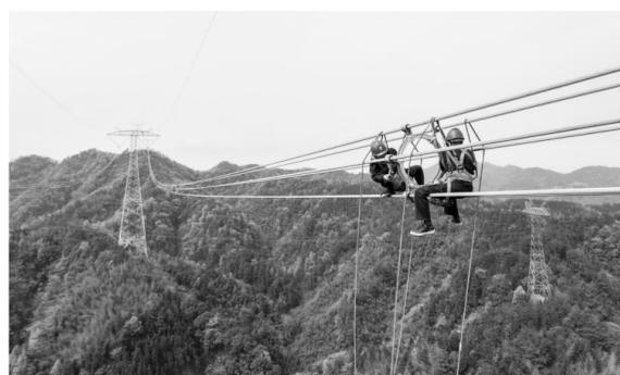
4月1日,在“宁电入湘”工程跨越宾金线架线施工现场,电力工人在安装间隔棒。“宁电入湘”特高压线路工程是我国首个沙漠、戈壁、荒漠地区风光电基地外送电的特高压工程,每年可从宁夏向湖南输送电量超360亿度,减少二氧化碳排放超1600万吨。新华社记者 陈思汗 摄
