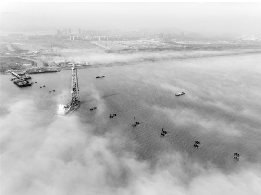
4月1日拍摄的浙江省舟山市青龙门特大桥西引桥水下桩基群(无人机照片)。当日,浙江省舟山市青龙门水域雾雾飘渺,由550根钢管桩串连而成的青龙门特大桥西引桥水下桩基群似巨龙出水,若隐若现,蔚为壮观。青龙门特大桥是跨海连岛工程——宁波舟山港六横公路大桥二期关键控制性工程,双主跨756米横跨青龙门水道,连接舟山佛渡岛和宁波梅山岛两座岛屿。新华社发
