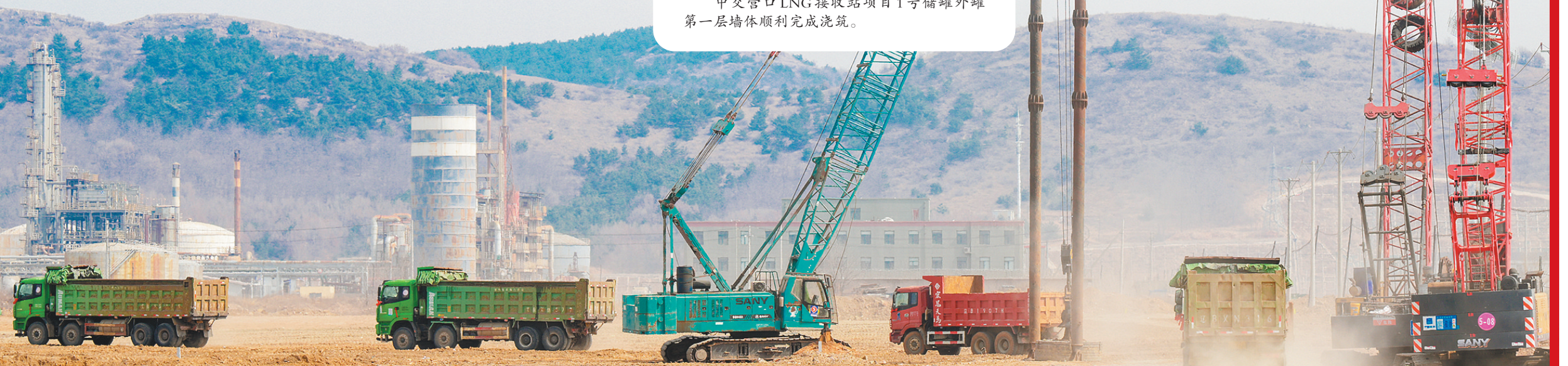
在大连市辽宁鼎际得石化新材料项目施工现场,运输车辆往来穿梭,大型作业设备有条不紊运转。
