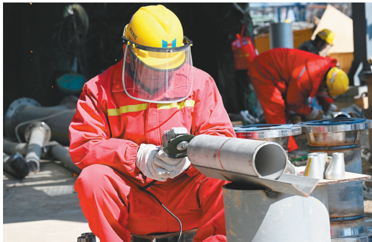
盘锦三力中科年产10万吨新材料项目建设现场,工人正加紧进行配套项目施工。
