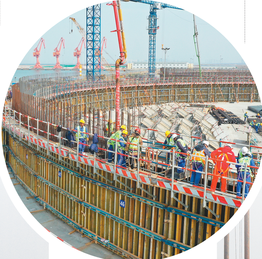
中交营口LNG接收站项目1号储罐外罐第一层墙体顺利完成浇筑。
