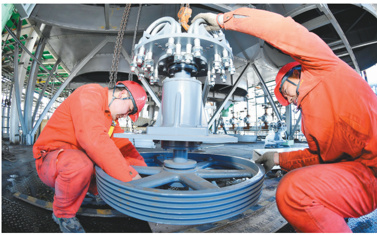
锦州石化40万吨/年针状焦装置建设现场,施工人员进行管线配制。 龚晓飞 本报特约记者 蔡壮 摄
