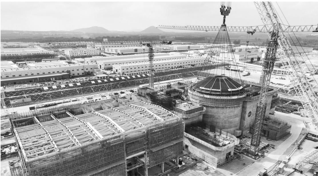
2月6日,海南昌江核电厂多用途模块式小型堆科技示范工程“玲龙一号”外穹顶在进行吊装作业(无人机照片)。
