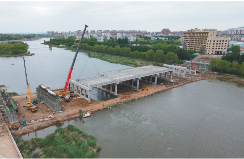
女儿河福州街大桥建设期间,起重机械正在吊装施工材料。
