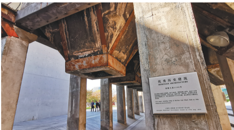
北票码头当年使用的煤料斗卸粮桥被评为“优秀历史建筑”,如今成为上海市徐汇滨江绿地公园内艺术空间的一部分。
