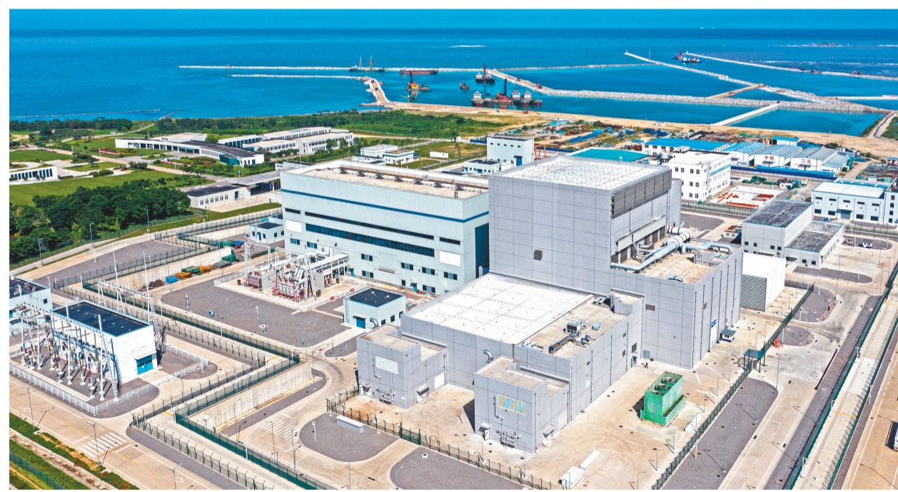
华能山东岛湾高温气冷堆示范工程外景(资料照片)。
