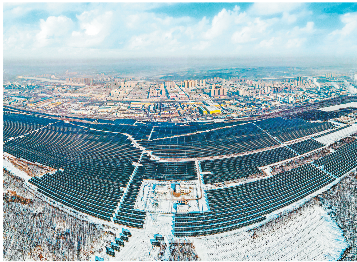
抚矿集团公司西舍场光伏发电项目的光伏“矩阵”绵延上千亩。
