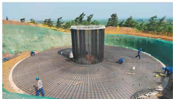
国电投风光火储多能互补项目正在进行风机基础锚栓安装。刘兴波 摄
