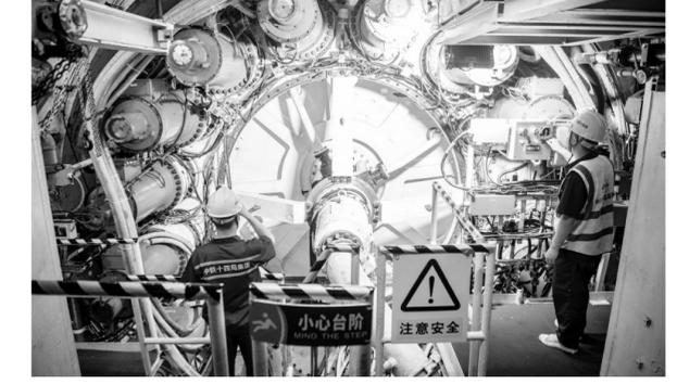
6月16日,工作人员在检查“长江号”盾构机运行情况。当日,重庆至黔江高铁(以下简称重黔高铁)重庆长江隧道开始盾构掘进。
