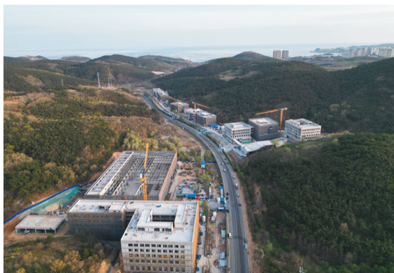
正在建设中的英歌石科学城。
