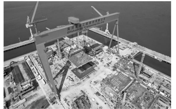
在海油工程天津智能化制造基地，渤中19-6凝析气田一期开发项目WHPM平台最后一块甲板正在吊装作业（5月8日摄，无人机照片）。近日，渤海油田渤中19-6凝析气田一期开发项目WHPM（井口平台）主体结构在海油工程天津智能化制造基地完成封顶，标志着渤中19-6凝析气田一期开发项目4座平台主体结构全部建造完成。据了解，渤中19-6凝析气田位于渤海中部海域，是中国东部第一个大型、整装、高产、特高含凝析油的千亿方凝析气田，也是渤海湾首个千亿方大气田。
