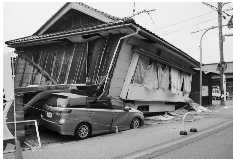
这是5月5日在日本石川县珠洲市拍摄的因地震倒塌的房屋。日本石川县能登地区5日下午发生6.3级地震。日本气象厅说地震不会引发海啸。据日媒报道,石川县珠洲市消防署已经收到两栋建筑物倒塌的报警,其他受灾情况正在统计中。新华社发
