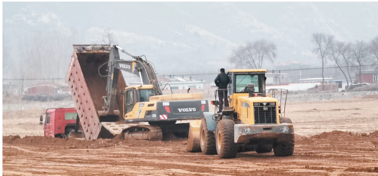
喀左县龙源欢乐谷项目正在紧张施工。
