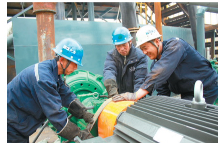
维修班现场实施技术改造。
