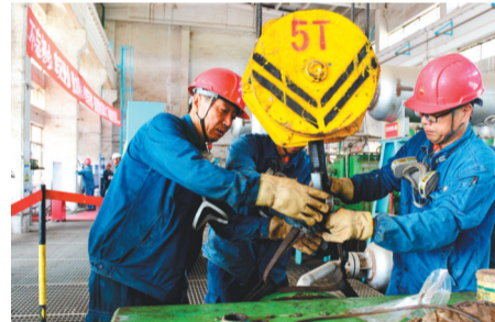
“铁人班组”对重要设备进行抢修。 本版图片均由省总工会提供
